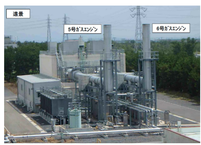
増設ガスエンジンシステム外観
