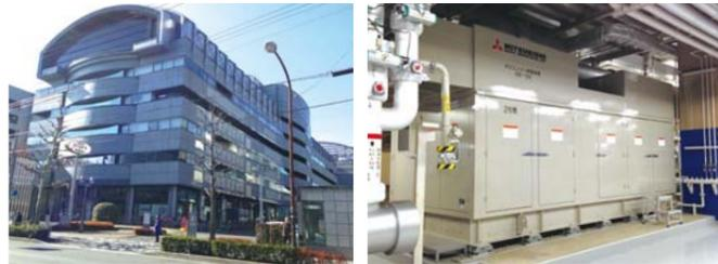
既設のストイキ式ガスエンジンとリプレース・増設の希薄燃焼式ガスエンジンとの異機種連系を実現し、非常時のデータセンター等重要負荷への給電・自立並列運転による電源セキュリティ向上を図った先導的事例。
