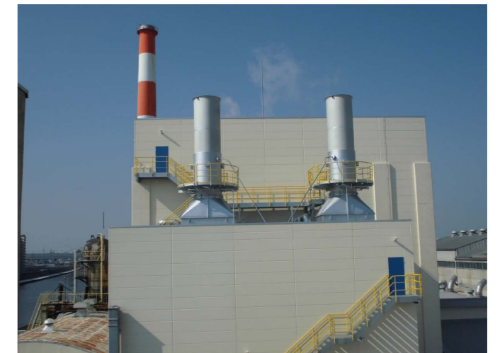
【更新GT 建屋外からの写真】
