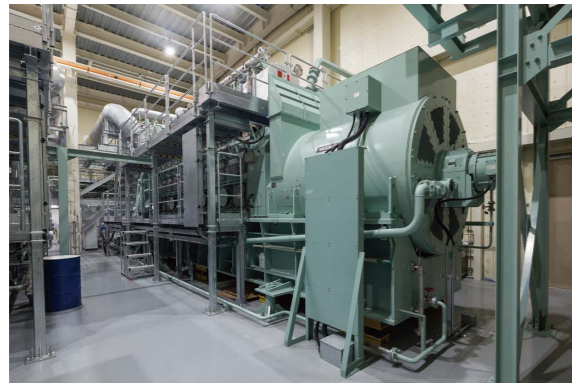
ガスエンジン
