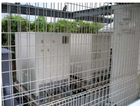
水素製造装置（屋上）
