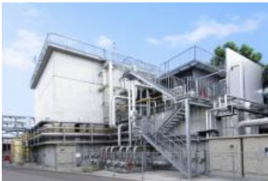
図-5 排水処理施設
