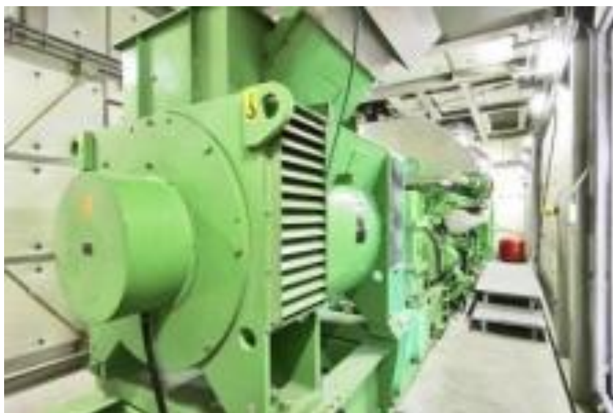
図-4 ガスエンジン発電機
