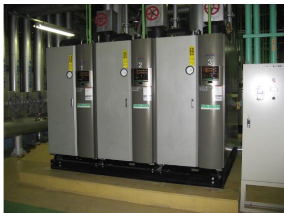
図 - 3 蒸気ボイラー
