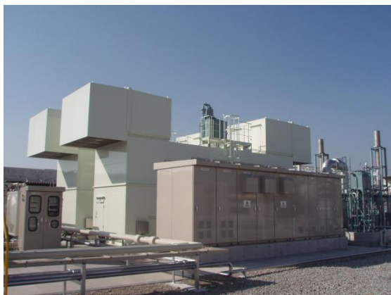
図 - 2 コージェネレーション外観
