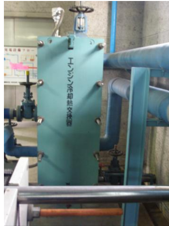
図-8 温水回収熱交換器
