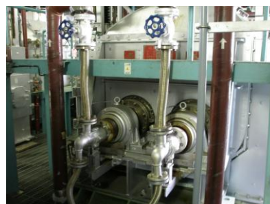
図-6 汚泥乾燥設備
