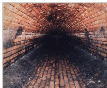
図-1 明治時代に築造されたレンガ造り馬蹄形渠 * 現在も西部地区で使用。 （函館市ホームページより）
