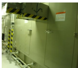
図-4 ガスエンジン発電ユニット
