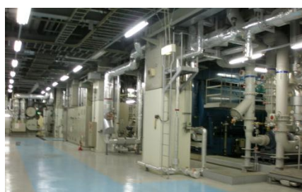
図-3 プラント全景
