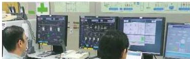
図-7 コントロールセンター
