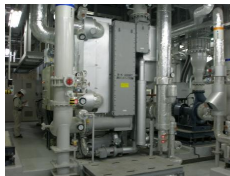
図-6 高効率排熱投入型蒸気炊き吸収 冷凍機 <超省エネジェネリンク>
