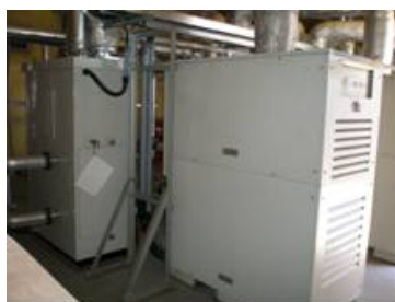
図-8 ガスタービン発電機 (30kW×4台)
