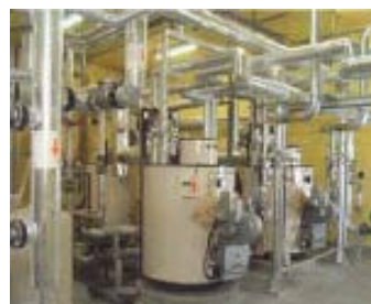
図-9 バイオガスボイラ (160,000kcal/h×2台)
