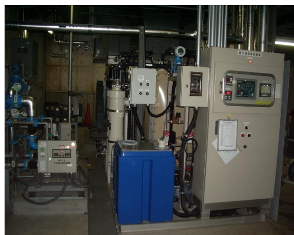
図－5 高密度膜ろ過装置
