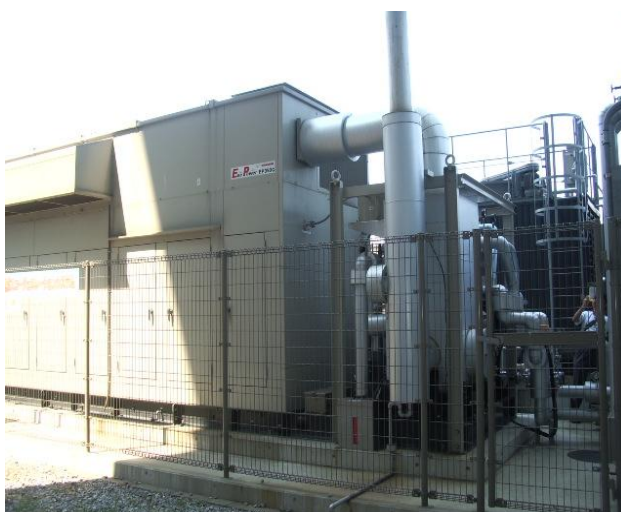
図-2 ガスエンジンコージェネレーション
