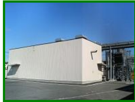
図-2 CGS 機械棟
