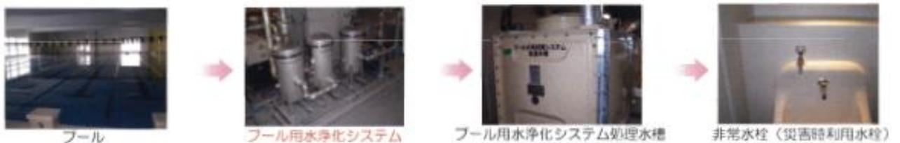
図-6 プール用水浄化システムと非常水洗(災害時利用水洗)(\*4)
