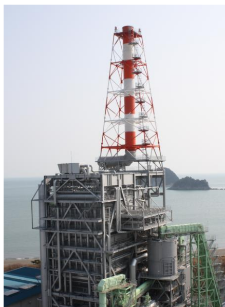
図-3 11号新エネルギーボイラ外観
