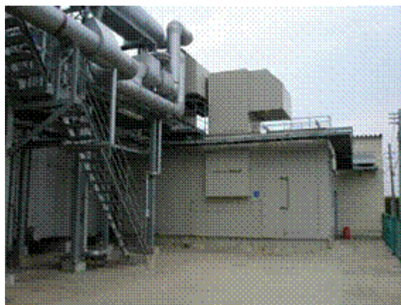
図-2 コージェネレーション外観
