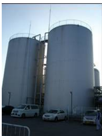
嫌気性廃水処理設備
