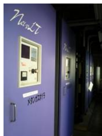
バイオガスボイラ
