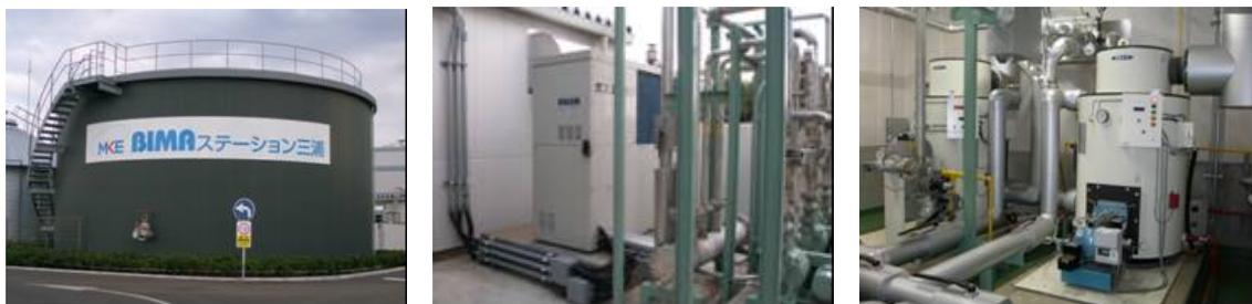
日発生し、ガスエンジンで発電することで（約 600kW/日）、本施設で使用する総電力量の約 11%を賄うことができる。また、ガスエンジンの排熱と温水ボイラで発生した温水は、
