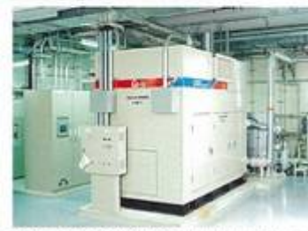
ガスエンジン発電機 (最大出力160kw)
