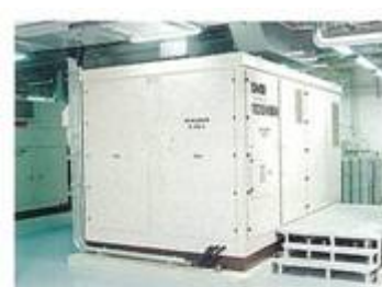
燃料電池 (最大出力200kw)
