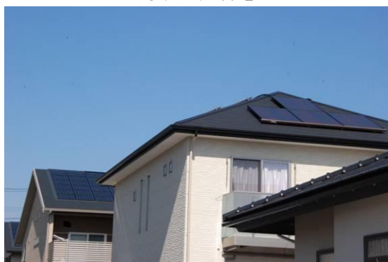
図-4 太陽光発電システム（*2）
