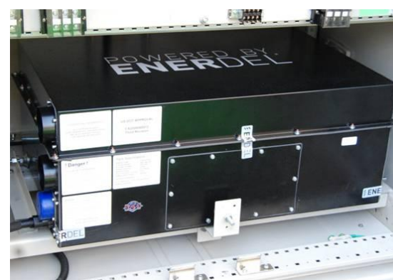
図-5 リチウムイオン蓄電池（*2）
