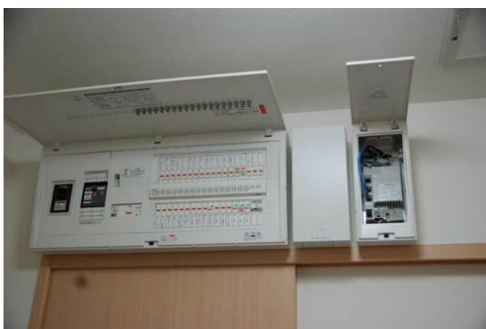
（左：対応分電盤 / 右：モニター用ユニット）
