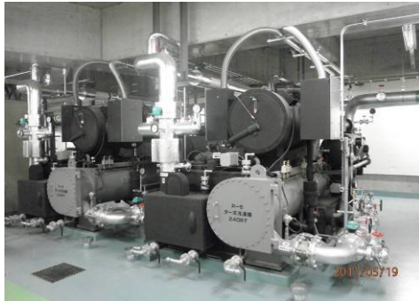
ターボ冷凍機 (三菱重工製)
