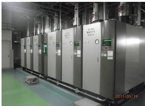
貫流ボイラ (三浦工業製)
