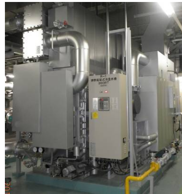
ジェネリンク（排熱投入型吸収式冷温水機） (三洋電機製)
