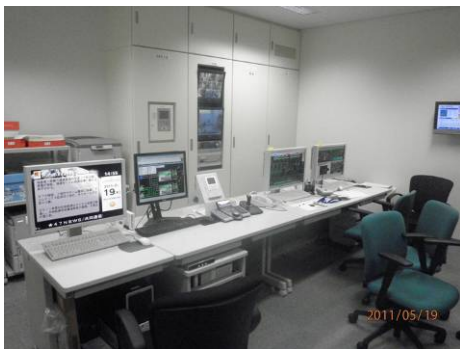
写真-4 中央監視室
