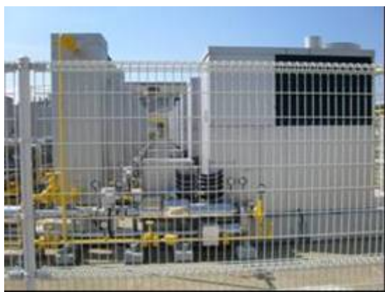
図-4 マイクロ CGS(右)とシロキサン除去ユニット(左)
