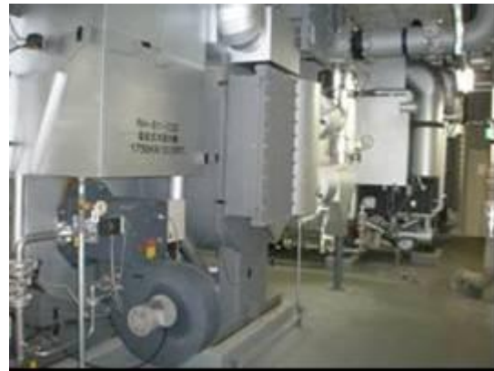
図-5 ガス焼き吸収冷温水機 冷房能力：1,758kW(500USRT)×4基 (1基は排熱投入型) メーカー：三洋電機(株)
