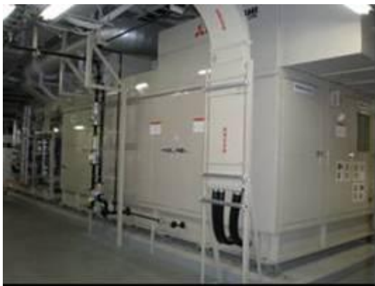
図-4 ガスエンジン発電設備 発電出力：845kW×2台 発電効率：約40% メーカー：三菱重工業(株)
