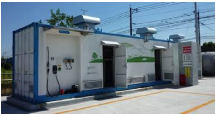
図-5 水素ステーション
