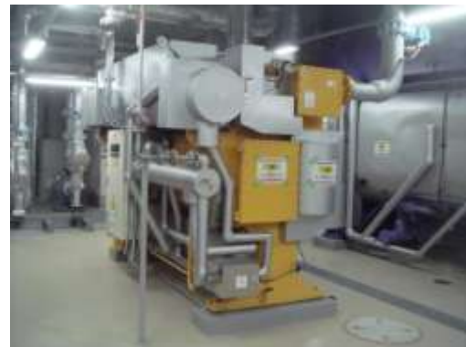
図-3 ガスコージェネレーションシステム 1,000kW×1 図-4 蒸気吸収冷凍機 705kW(200RT)×1
