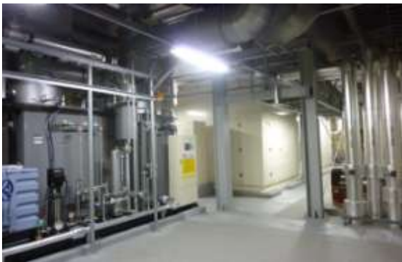
図-3 ガスコージェネレーションシステム 1,000kW×1 図-4 蒸気吸収冷凍機 705kW(200RT)×1
