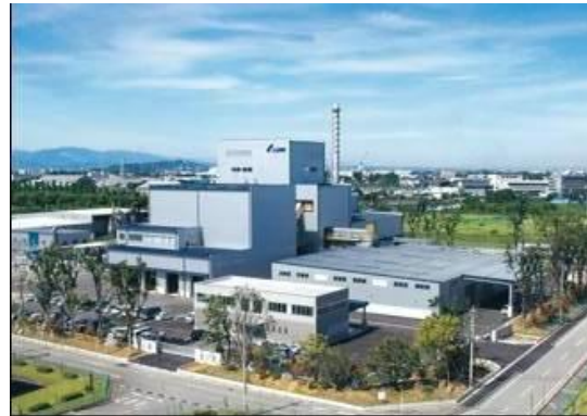
図-3 エネルギーセンター外観 (*3)
