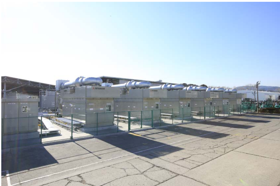
ガスエンジン設置状況 (*1)
