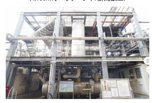
図-4 アンモニア吸収式冷凍機
