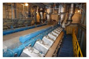
図-5 ガスエンジンコージェネレーション (6,030kW、パッケージャ: 日立造船)
