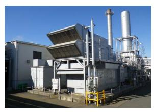
図-3 ガスタービンコージェネレーション (4.100kW、パッケージャ:新潟鉄工)
