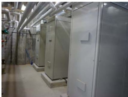
図12. CGS設備外観
