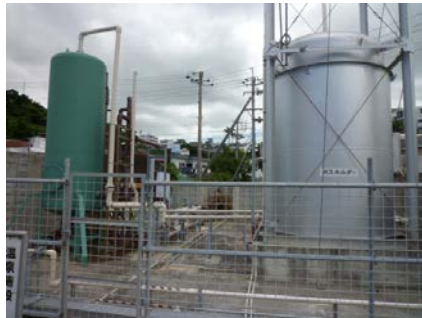
図7. 温泉付随天然ガスホルダー (右端) 温泉付随天然ガスセパレータ (左端)
