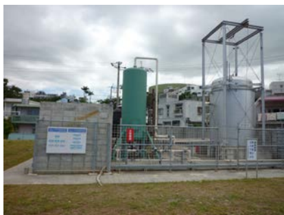
図5. 温泉天然ガス発生施設全体外観
