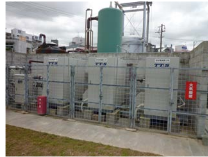
図8. 温泉付随天然ガス前処理装置
