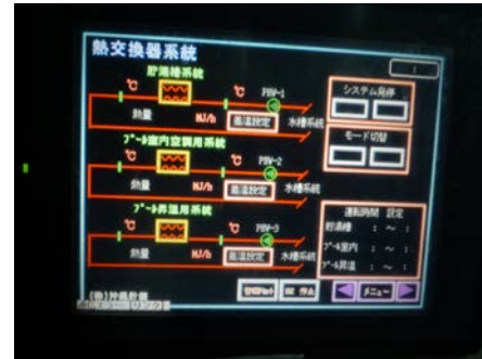
図15. 廃熱利用制御盤
