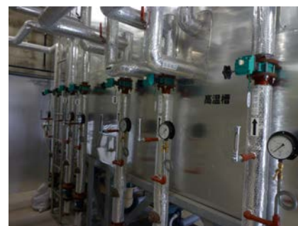
図13. 廃熱回収タンク
