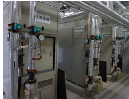
図11. CGS設備外観
