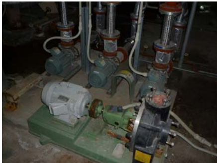
図14. 廃熱利用ポンプ
