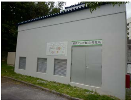
図10. 発電所（建屋）の外観
