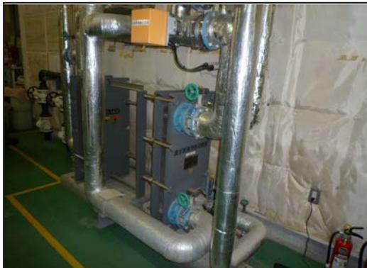
図-4 廃熱回収用熱交換器
