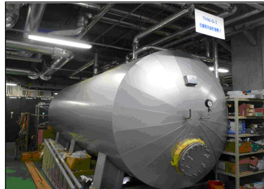
図-5 廃熱回収用ストレージタンク
