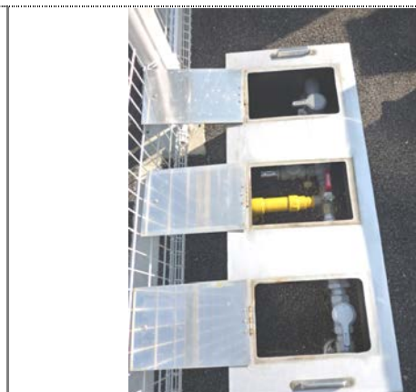
図-10 ガス切替バルブ外観
