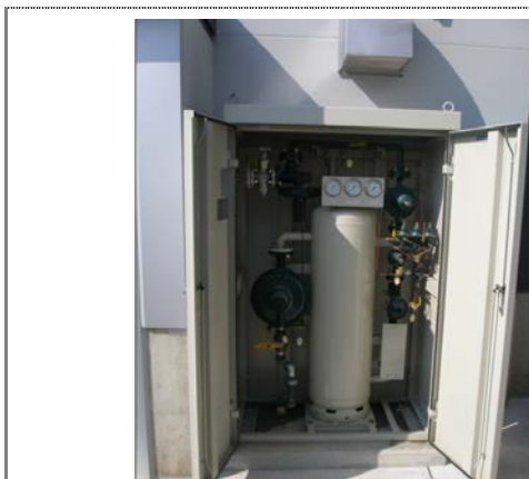
図-9 本発生装置外観
