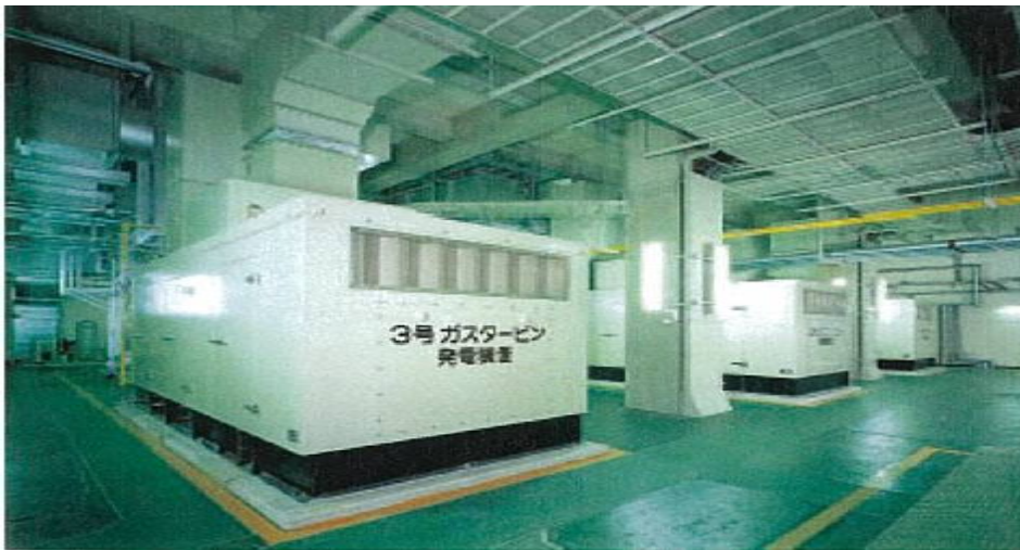
図 - 5 ガスタービンコージェネレーション
