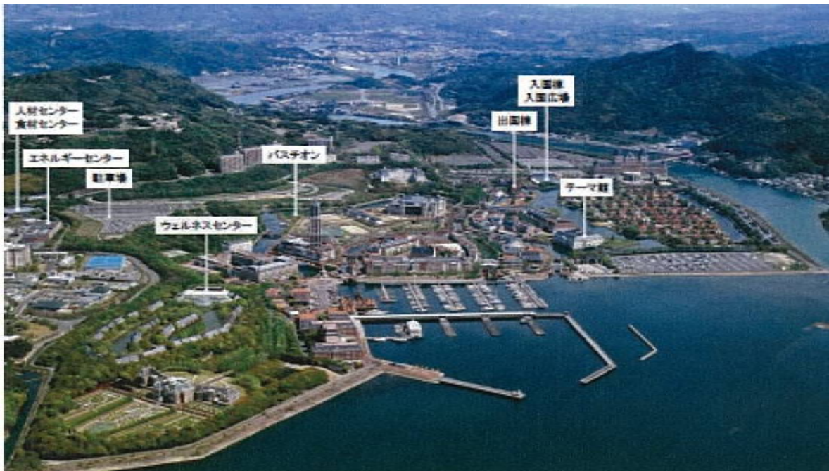
図 - 2 次世代エネルギーパークの全景
