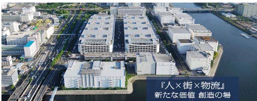
写真-1. 建物外観
