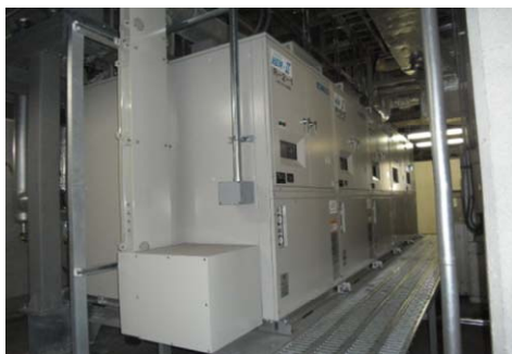
写真-6 水冷モジュラーチラー外観(1)
