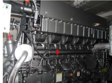
写真-3 ガスエンジン本体外観
