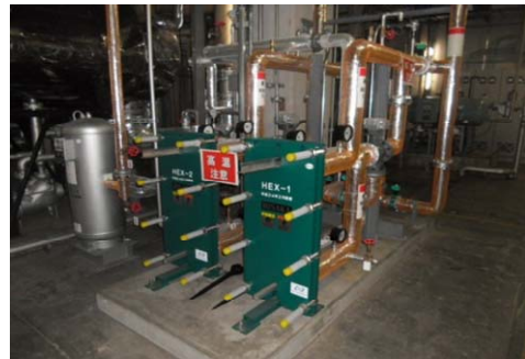
写真-8 熱交換器外観
