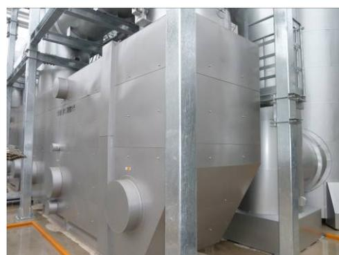
図-3 排熱蒸気ボイラ外観
