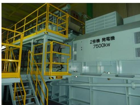
図-2 ガスエンジン発電機外観
