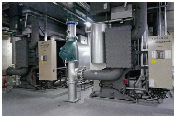
ガス吸収式冷温水発生機
