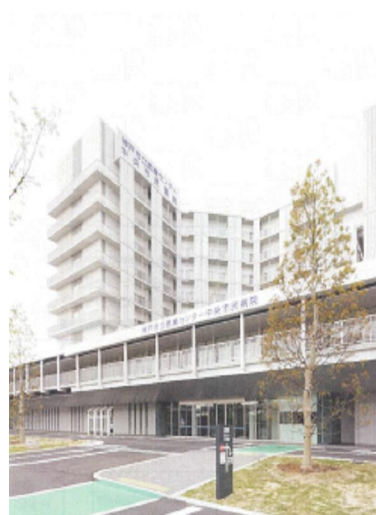
神戸市立医療センター 全景
