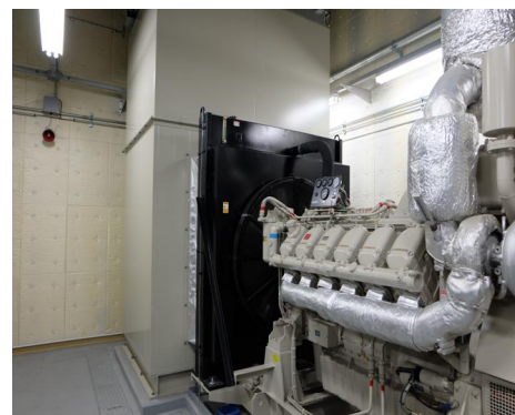
非常用自家発電装置
