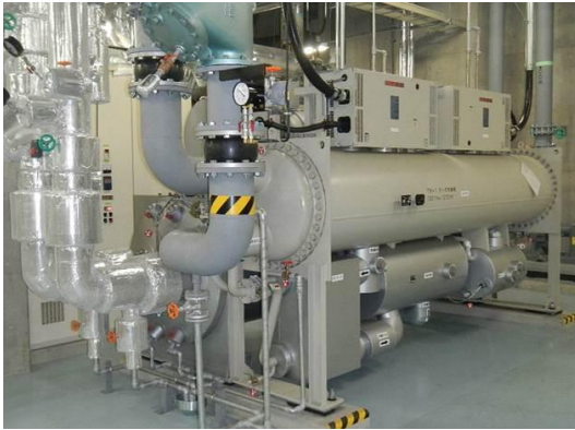
ターボ冷凍機
