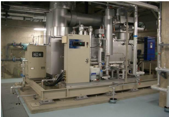
CGS 排熱ボイラ
