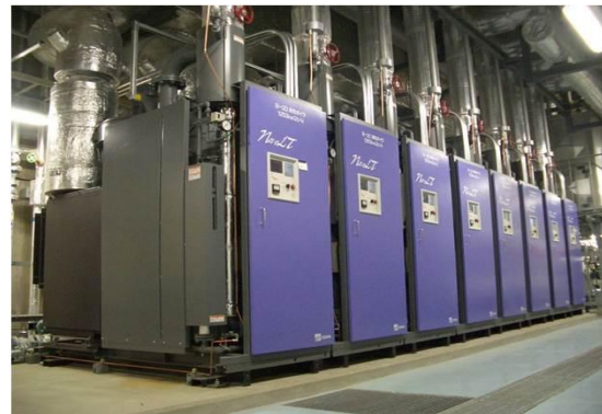
ガス焚貫流ボイラ
