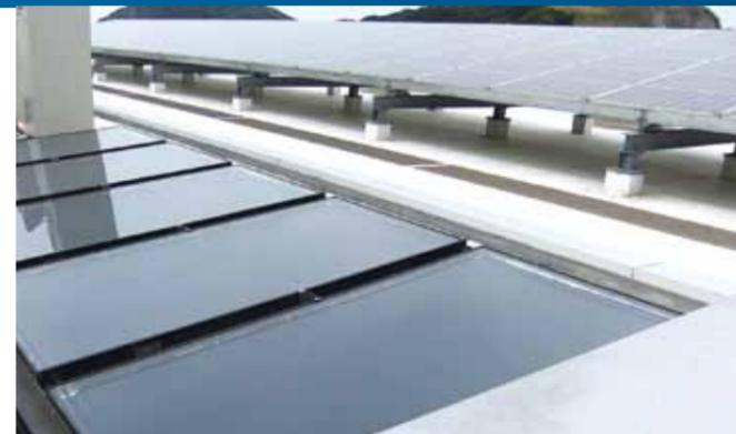
写真③ 太陽熱利用温水供給設備(矢崎エナジーシステム(株))
