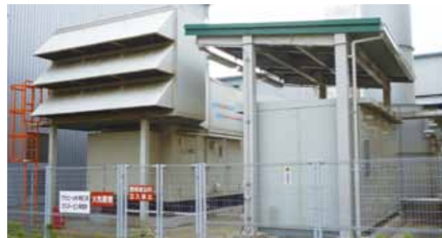
写真① ガスタービン発電装置と発電機盤
