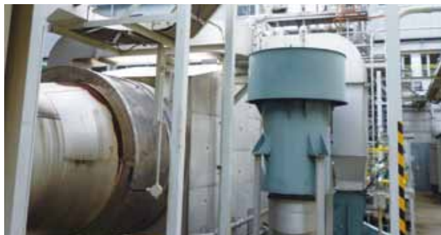
写真② 追焚きバーナー付排ガスボイラー
