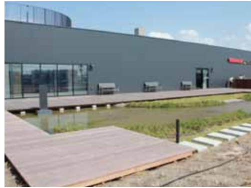
写真② ヤンマーテラス
