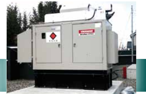
写真⑤ 非常用発電装置
