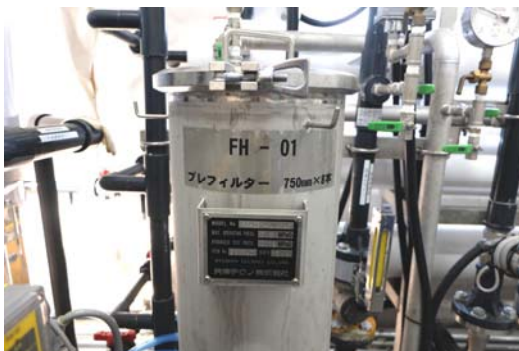
井水浄化装置 (フィルター部)
