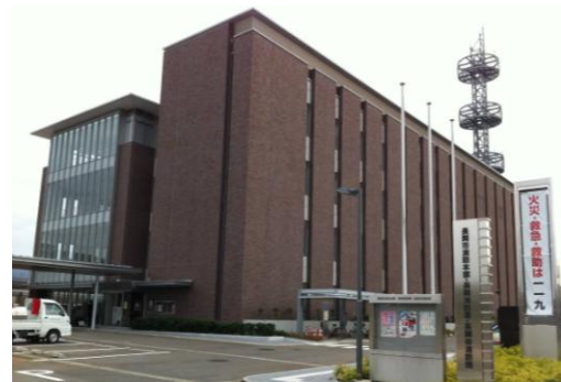
写真-1 長岡市消防本部 外観
