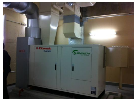
防災用自家発電装置
