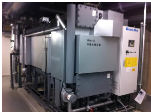
ガス吸収式冷温水機
