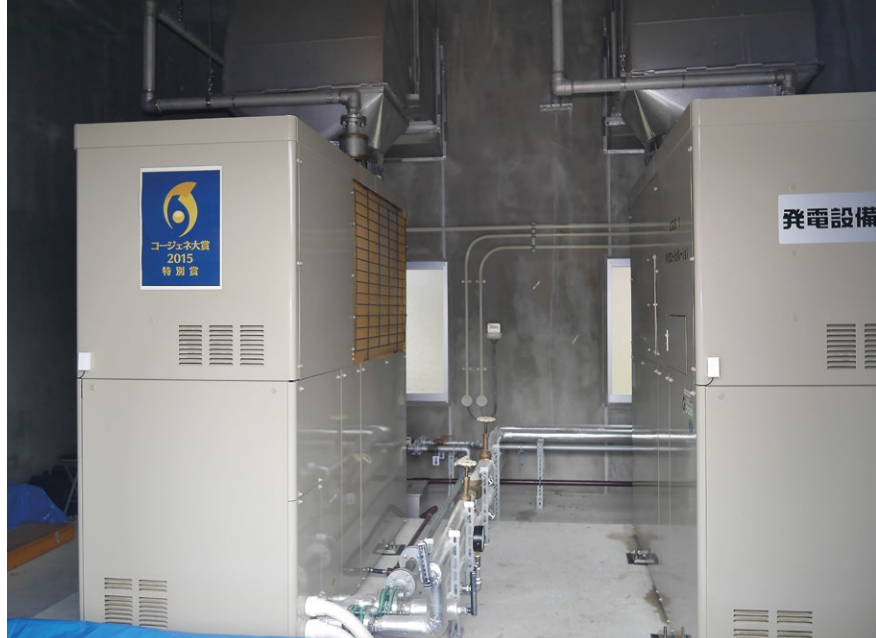
ガスエンジン・コージェネ (25kW×2台)
