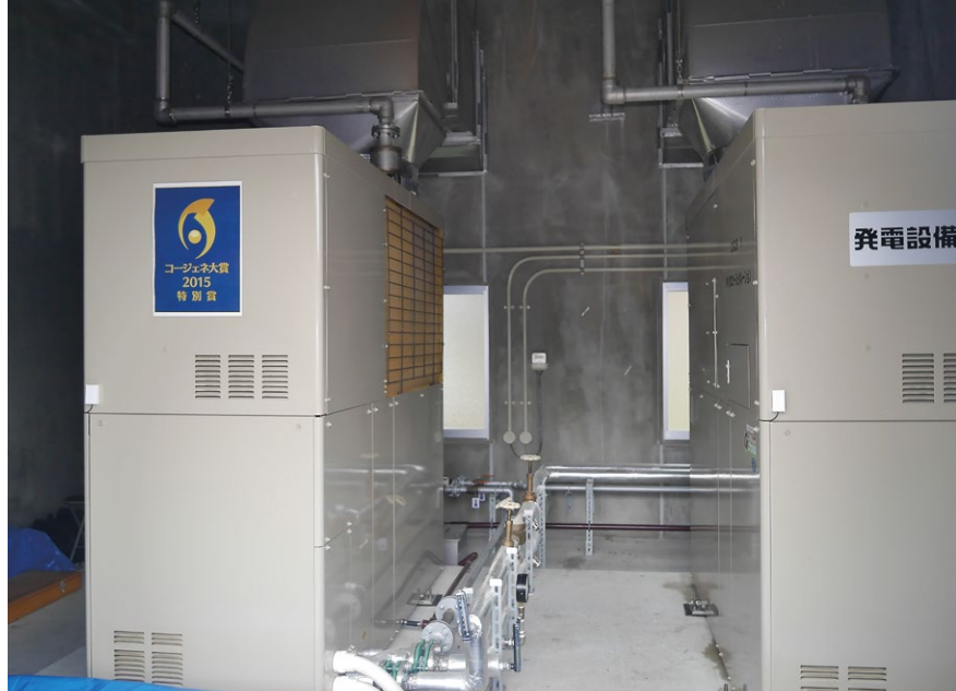
ガスエンジン・コージェネ (25kW×2台)
