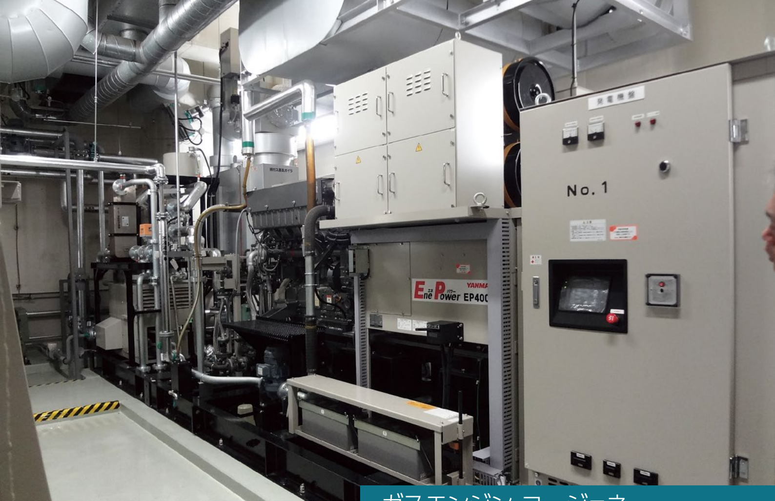
ガスエンジン・コージェネ (400kW×2基)
