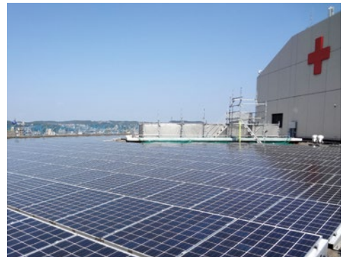
太陽光発電:各棟の屋上5カ所に合計308kWを設置
