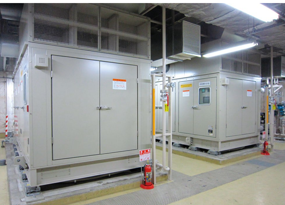
ガスエンジンコージェネ(450kWx2基)
